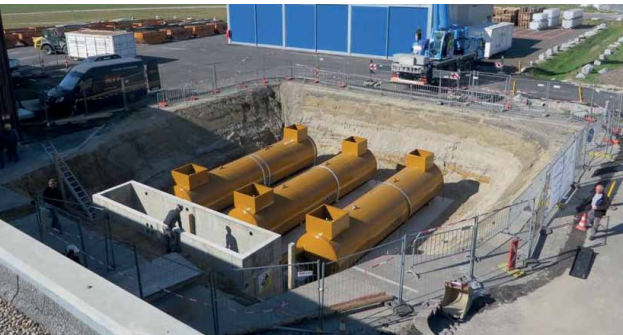
Drei neue, unterirdische Abwassersammeltanks mit je 30m 3 Fassungsvermögen
