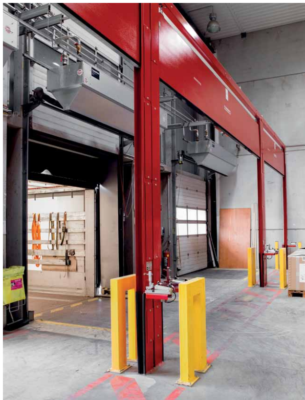
Löschwasserrückhaltebarrieren bei allen Ausgängen
