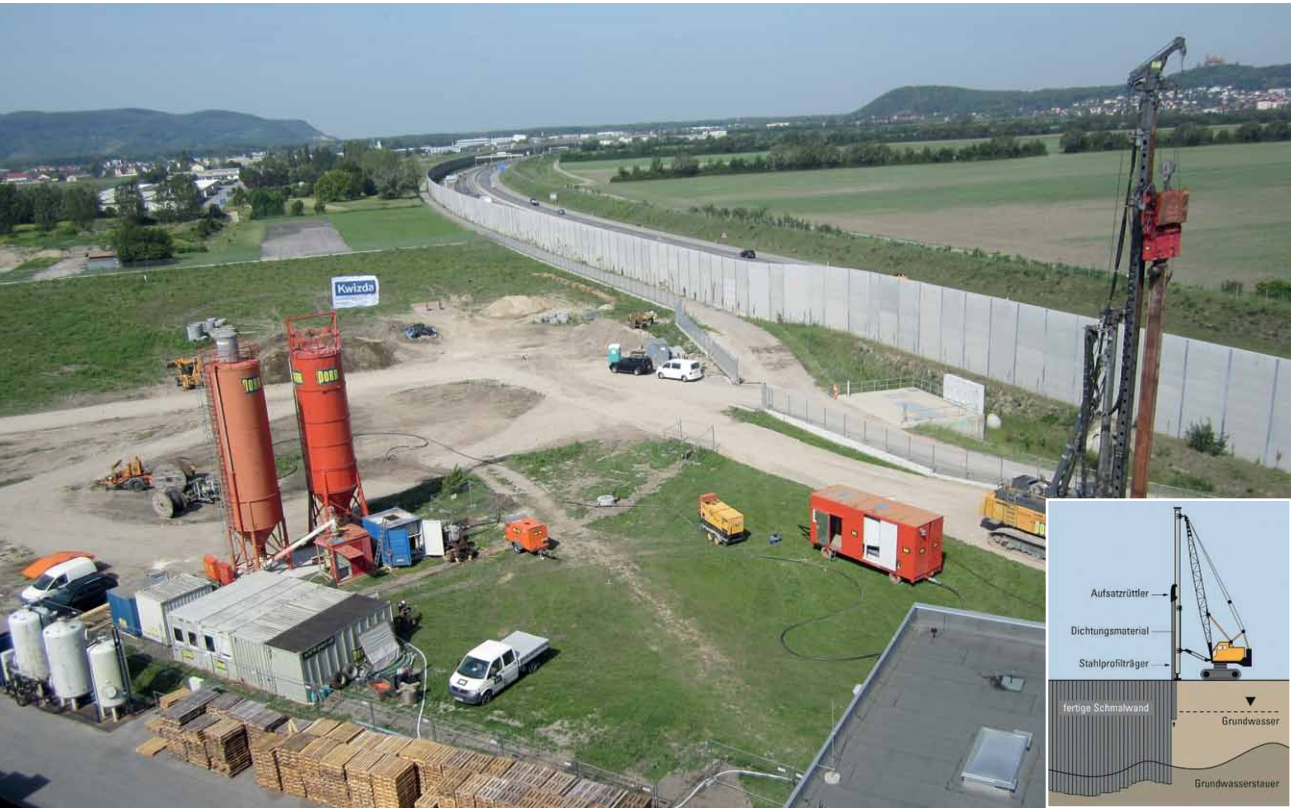
Rambagger mit Suspensions-Silos
