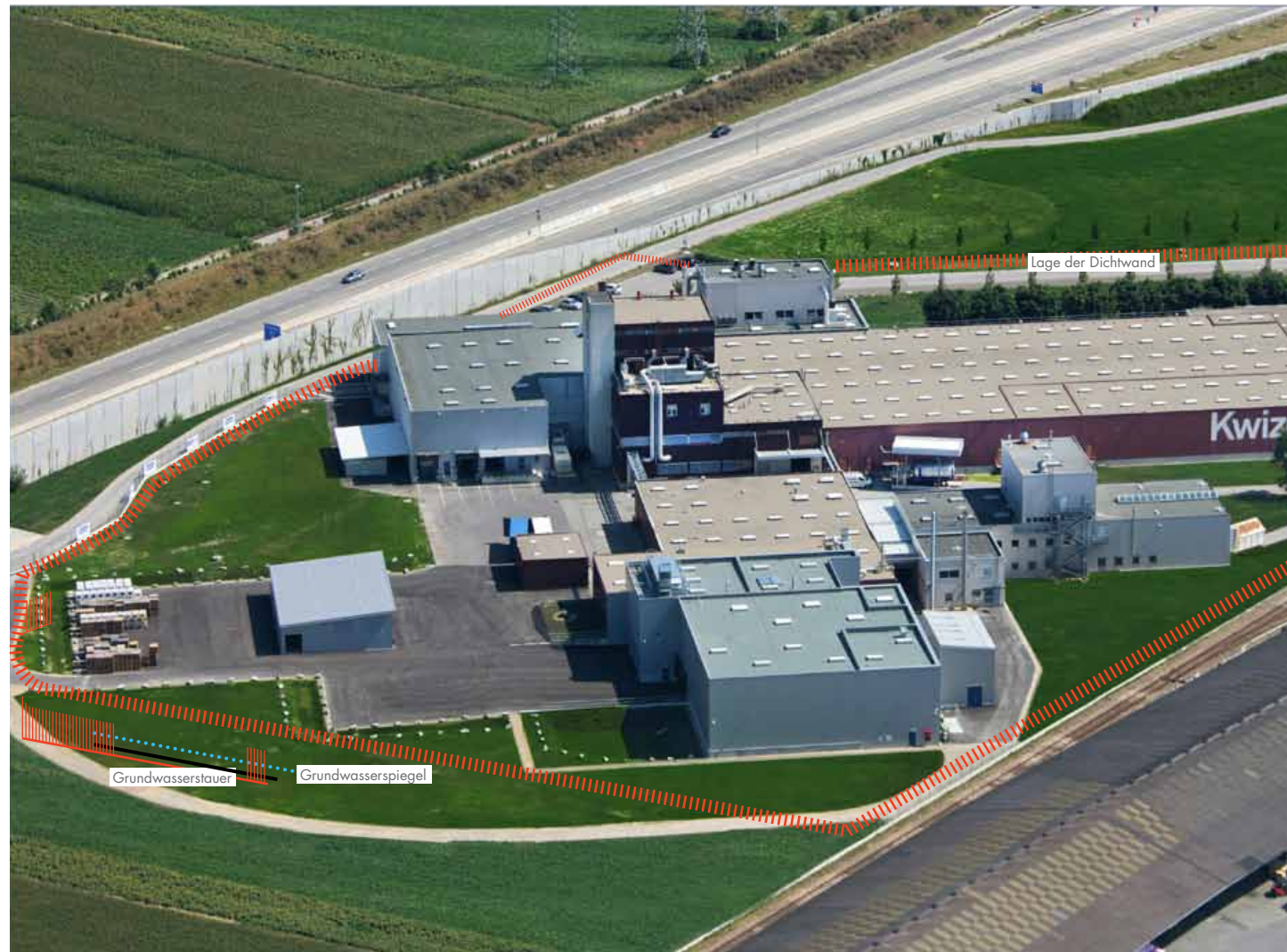
Umschließung des gesamten Werksareals mit einer Dichtwand
