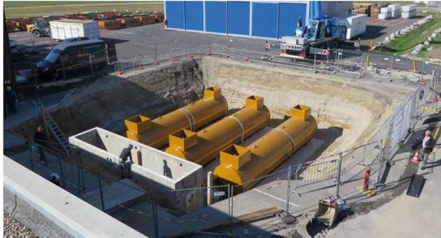
Drei neue, unterirdische Abwassersammeltanks mit je 30m<sup>3</sup> Fassungsvermögen
