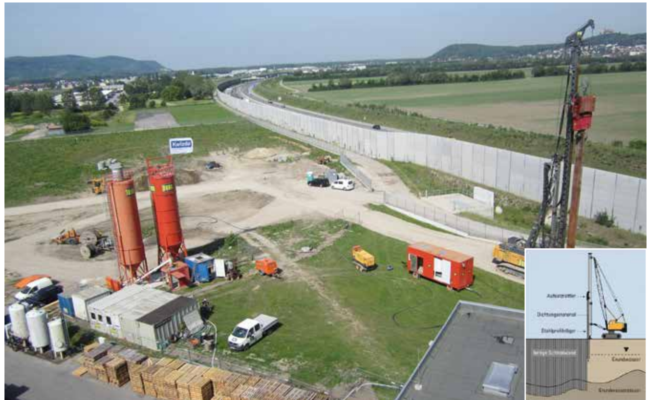
Rambagger mit Suspensions-Silos
