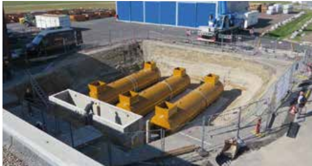
Drei neue, unterirdische Abwassersammeltanks mit je 30m 3 Fassungsvermögen
